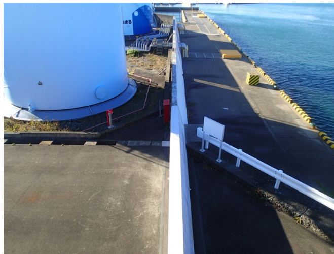
工事施工箇所
