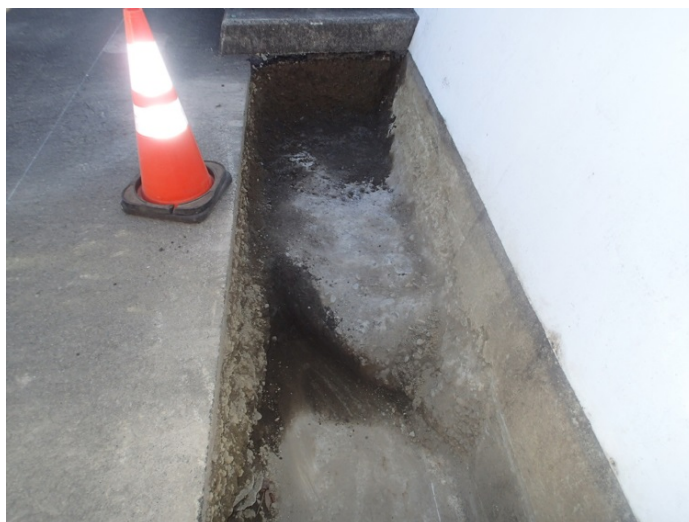
胸壁と一体となっている埋設構造物
