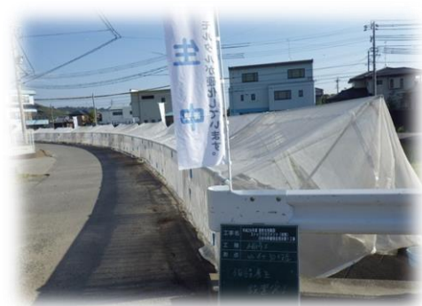
施工後も1～2日以上養生を設置
