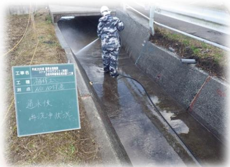
通水後の汚れを除去
