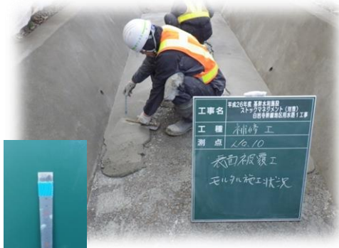
作業員による厚さ確認
