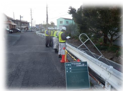
施工箇所の確認
