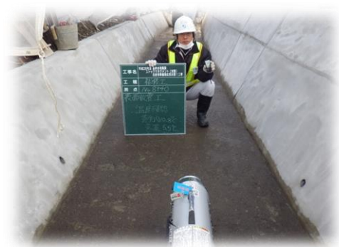
施工前壁面温度測定
