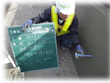
施工中の厚さ確認
