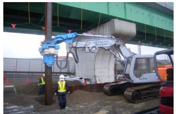
施工状況写真
