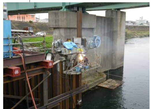
油圧式圧入(ウォータージェット併用)工法
