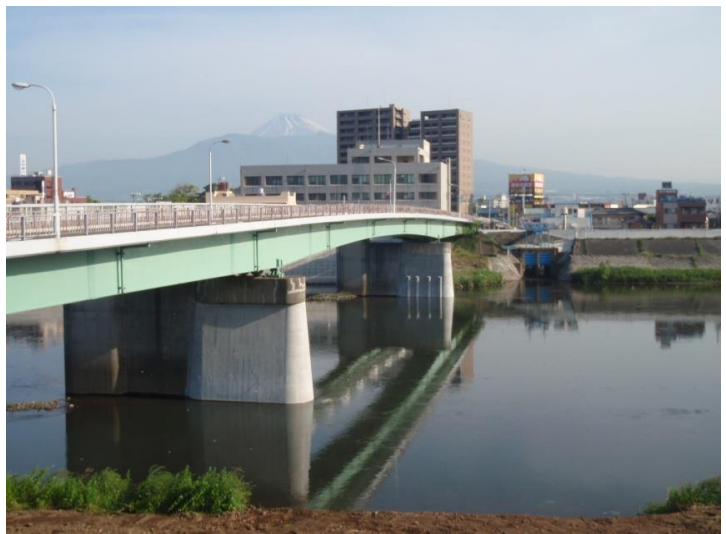
河川部橋脚補強工 完成
