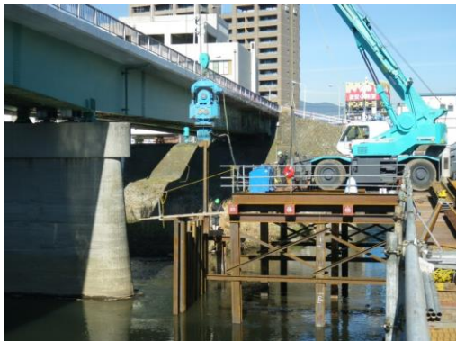
上部橋梁影響外のバイプロハンマ打設
