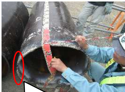
鋼管先端に取り付けたメタルクラウン
