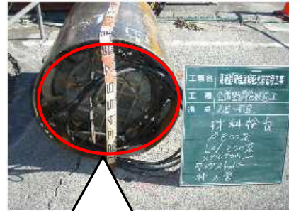
鋼管内に設置したキングストッパー
