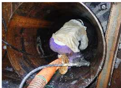
【土砂搬出状況】
