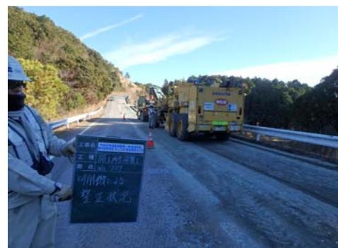
路面切削機による不陸整正状況
