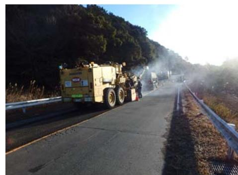
路面切削機による切削すり付け状況
