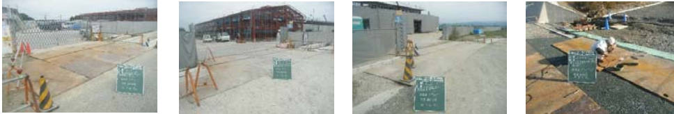
(任意敷鉄板設置状況)
