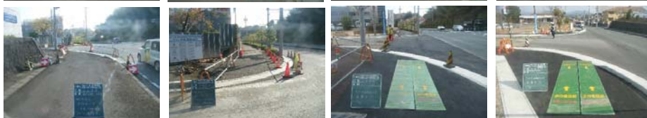
(歩行者通路 明示状況)
