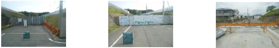
(北側立入 防止柵設置)
