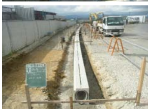
・側溝据付完了全景
