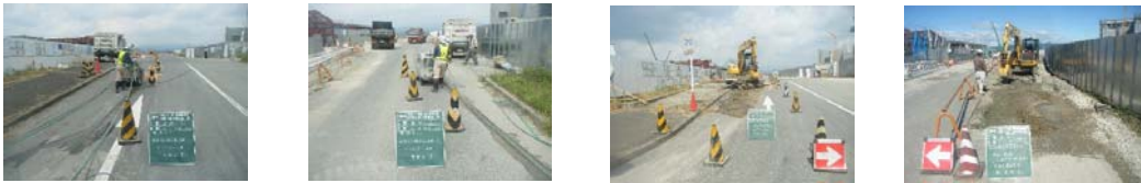
(既設As版縦断切断・通路確保分割施工状況)
