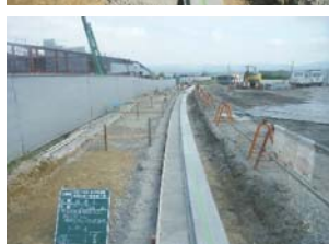
・歩車道B均しCo基礎完了全景
