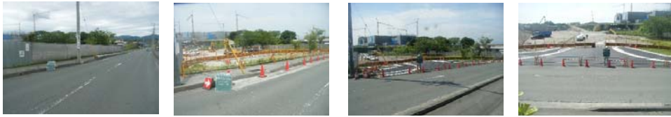
(迂回路出入口 設置状況)
