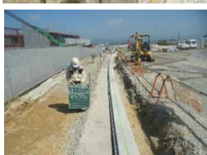
・歩車道B砕石基礎完了全景
