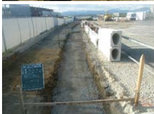
・基礎砕石敷設完了全景
