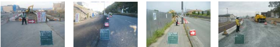
(交通誘導員配置誘導状況)
