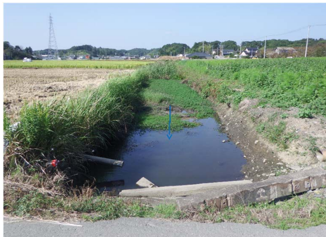
写真 現況排水路
