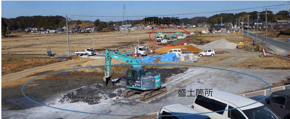
写真 施工状況(全景)
