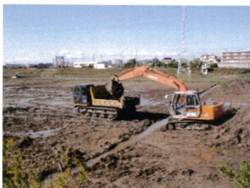
土側溝設置状況
