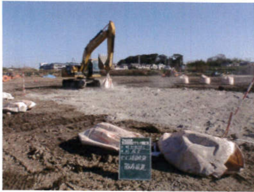
セメント系固化材散布状況
