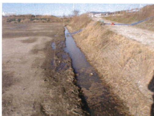
土側溝設置状況
