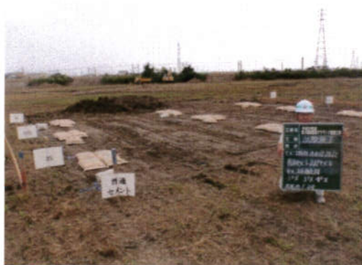
改良材配置状況
