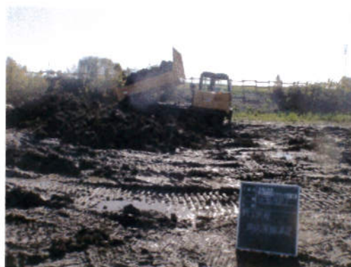
場内運搬状況(残土)
