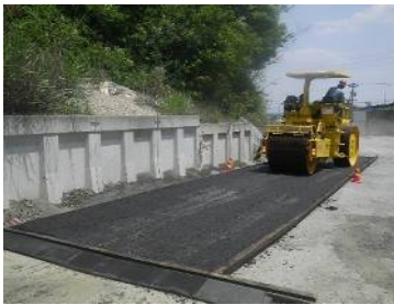
振動マカダムローラ転圧状況
