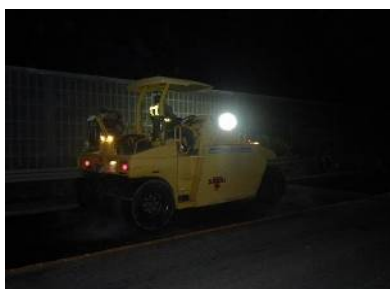
散水転圧状況
