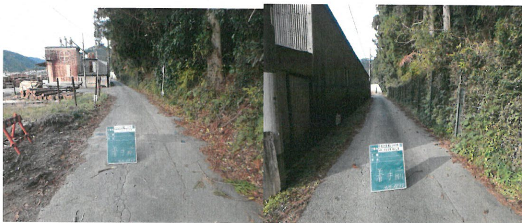
工事着手前の製材所付近の様子
