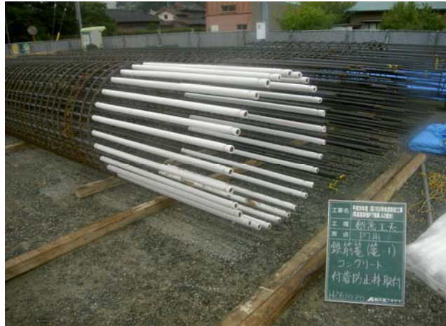
写真1 付着防止材設置
