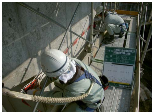
写真5 フルハーネス型安全帯の使用
