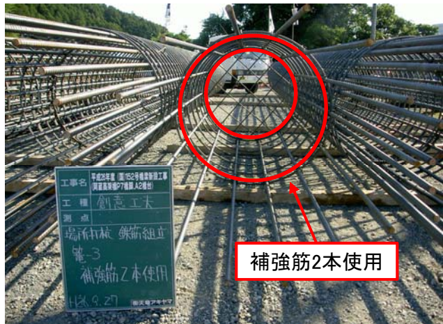
写真2 補強筋の追加
