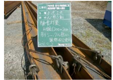
(写真3) H鋼吊金具緩衝材
