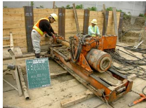
(写真4) アンカー削孔機
