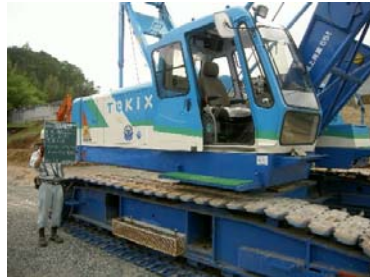
(写真2) クローラークレーン
