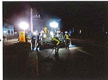
基層舗設状況
