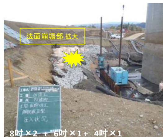
水面下 約5m にて矢板締切施工
