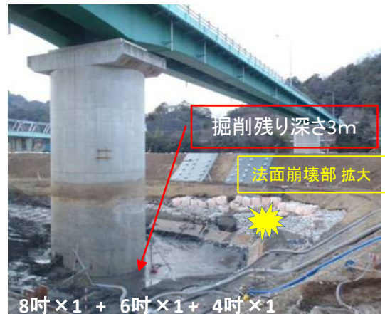
水面下 約5m 掘削状況
