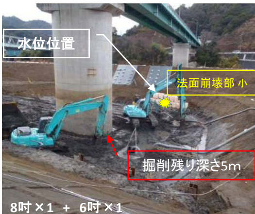
水面下 約3m 掘削状況
