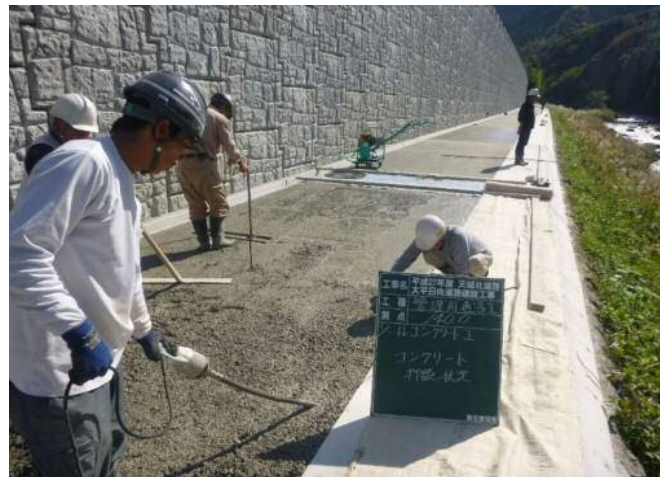
コンクリート締固め状況
