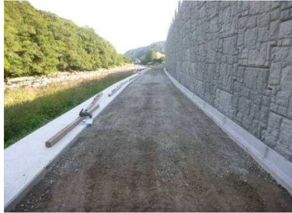
シールコンクリート施工前
