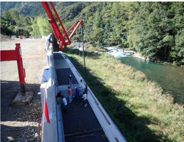
コンクリートポンプ打設状況
