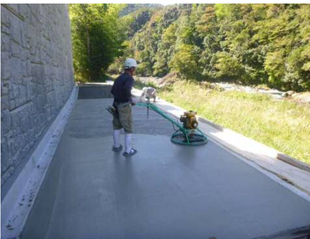
トロウエルによる均し状況
