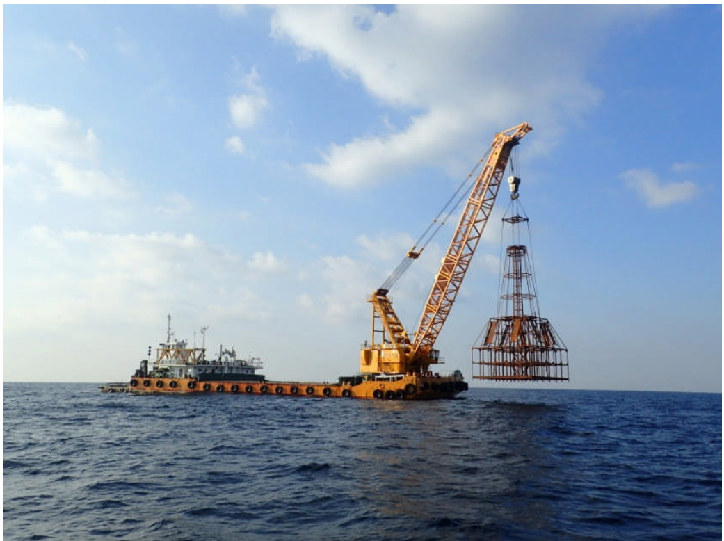
魚礁の沈設状況全景
