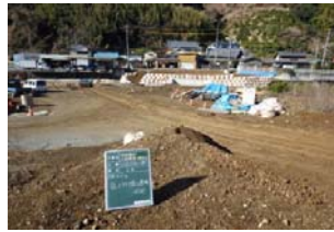
③運搬通路設置
