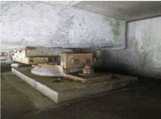
支承交換前 (既設支承)
