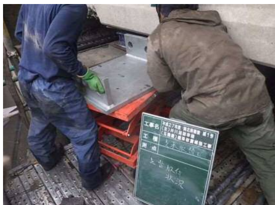
上部沓取付け状況
