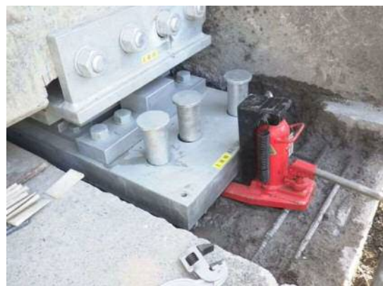
下部沓取付け状況
