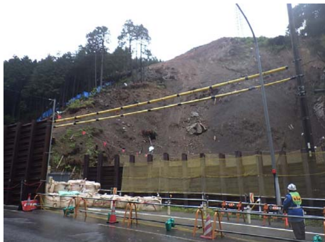
写真-4 ネット設置状況
