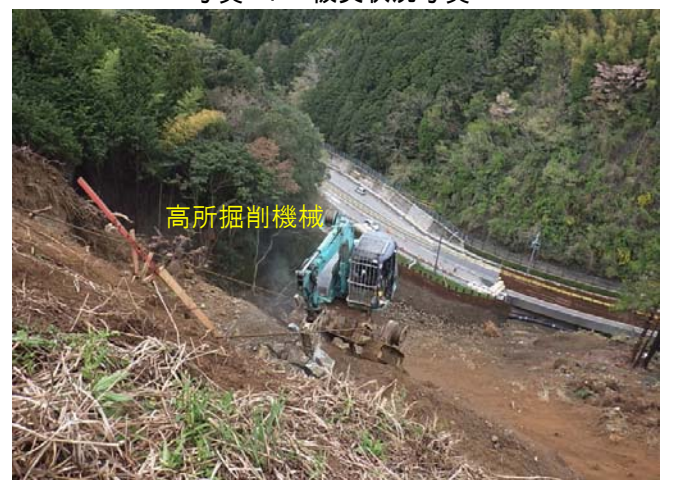
写真-2 掘削排土状況
