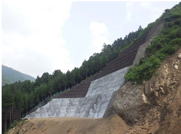
写真-8 地すべり上部の掘削完了状況
