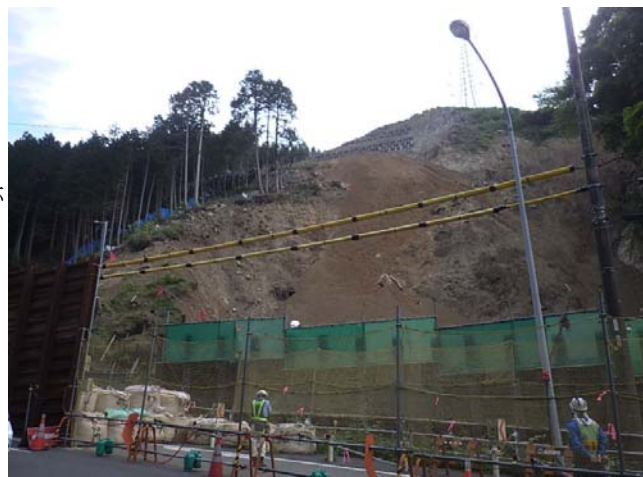
写真-6 ネット設置状況
