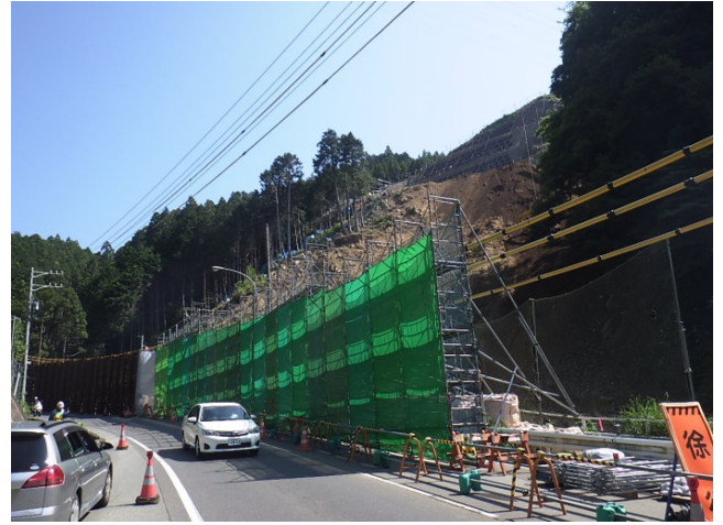
写真-7 ネット設置状況
