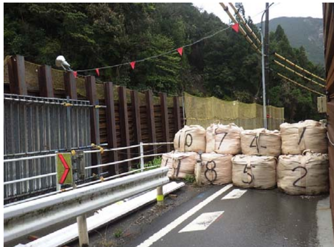
写真-5 ネット設置状況
