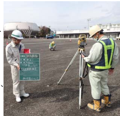
TS出来形実施状況
