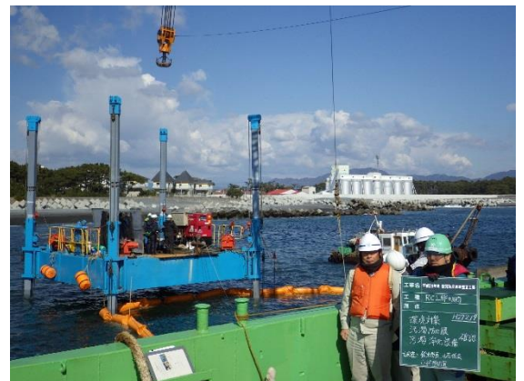
(発注者による水質汚濁防止対策状況確認)
