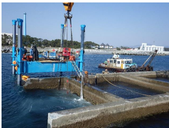
(ワイヤーソーによる切断作業状況)
