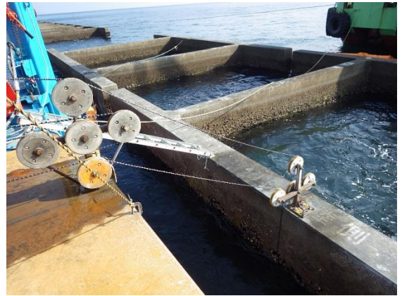
(コンクリート切断用 鉄製ワイヤーソー)
