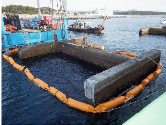
(シルトフェンス設置状況)
