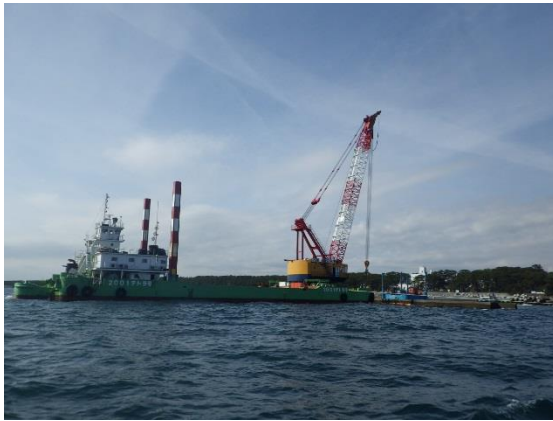
(使用した 300 t 吊起重機船)
