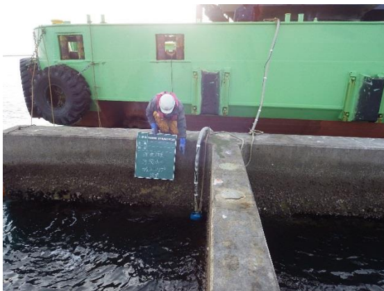
(水中ポンプ設置状況)
