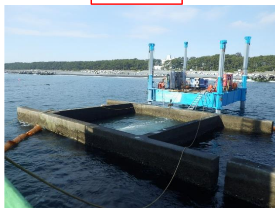
（海上離岸堤での使用状況）
