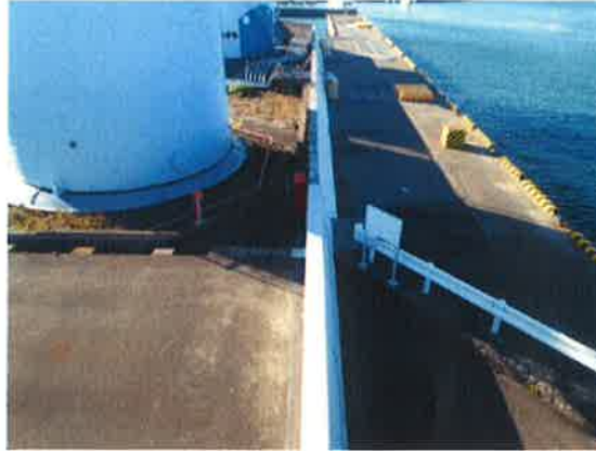
工事施工箇所
