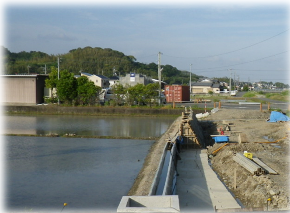
水路施工完了(重力式擁壁施行中)
