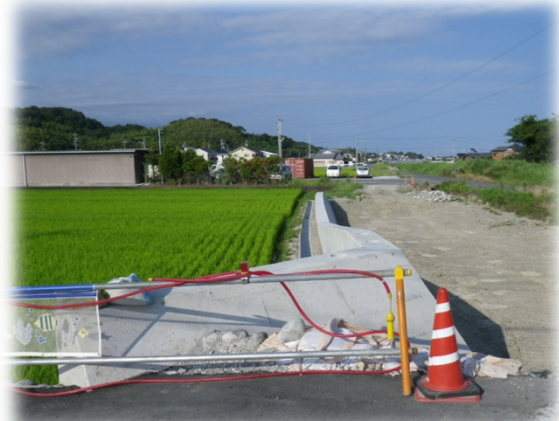
重力式擁壁施工完了
