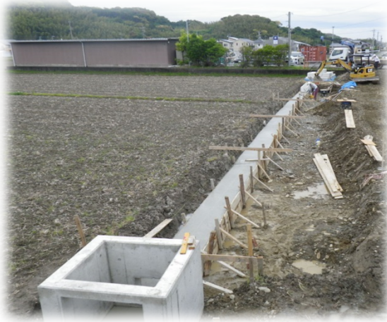
水路均しコンクリート打設
