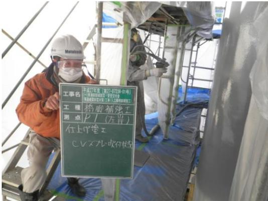
仕上げ塗工 CV スプレー吹付状況
