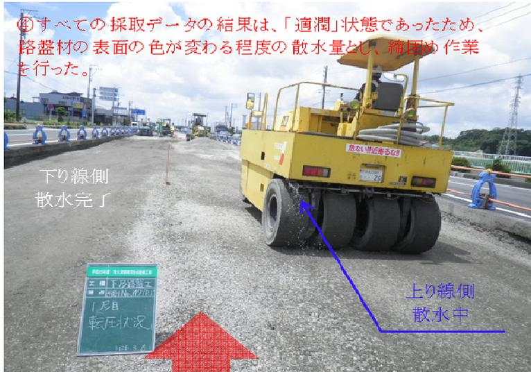
④すべての採取データの結果は、「適潤」状態であったため、路盤材の表面の色が変わる程度の散水量とし、締め固め作業を行った。
