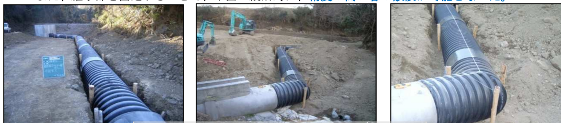
写真 松杭による高密度ポリエチレン管の固定
