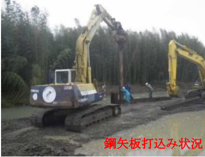
鋼矢板打込み完了
