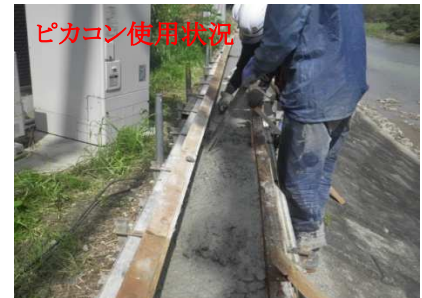
NETIS登録番号:SK-040007-VE 「気泡除去器具「ピカコン」」 ピカコン細部
