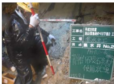
静的破砕材 施工状況
