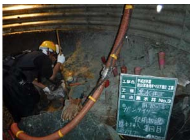
動的破砕材 施工状況
