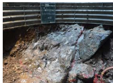
静的破砕材 施工結果
