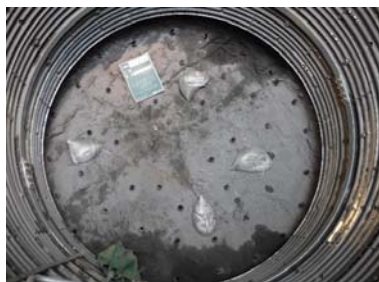
火薬 施工状況
