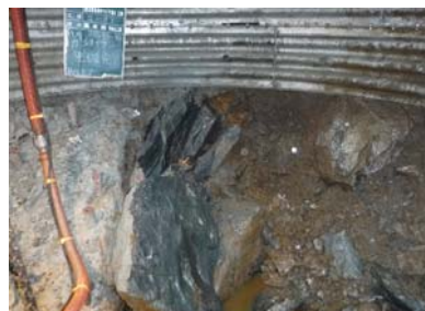
動的破砕材 施工結果
