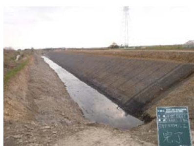
写真(6)：ジオテキスタイル完了
