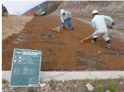
写真(7)：客土敷均し状況
