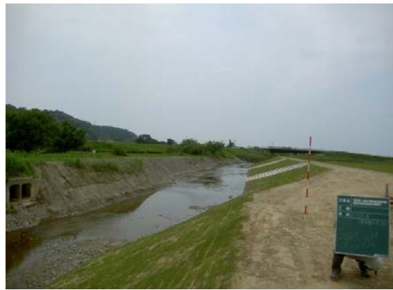
写真：完成(中間部)
