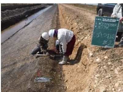
写真(5)：U字ピン打設状況
