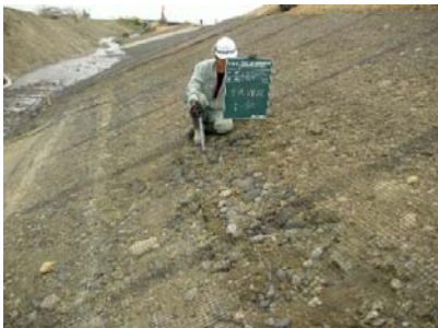
写真(3)：空隙確認 近景
