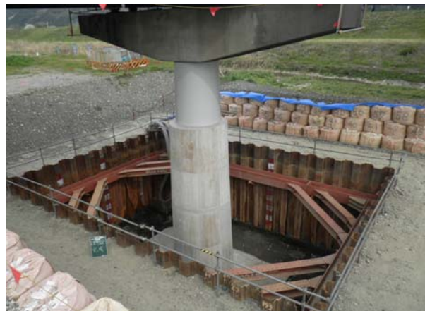
矢板打込み完了(不可視部完)
