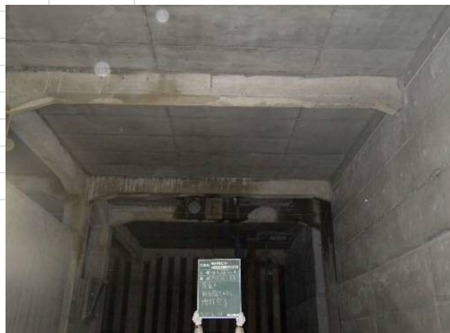
頂版下無収縮モルタル完了
