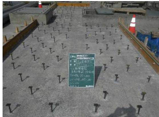
せん断補強筋完了
