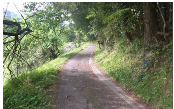
図-2 工事着手前状況
