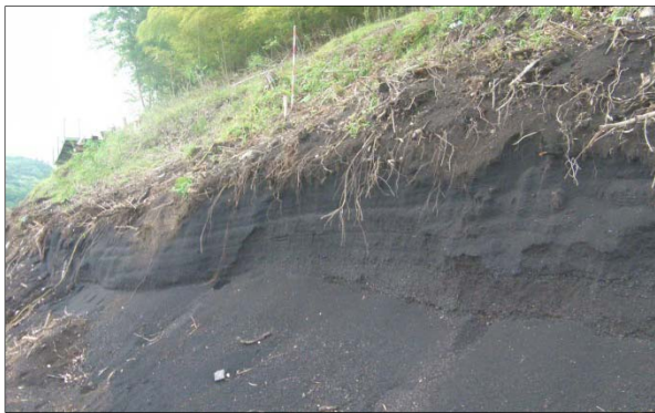
図-3 工事箇所付近でのスコリアの堆積状況
