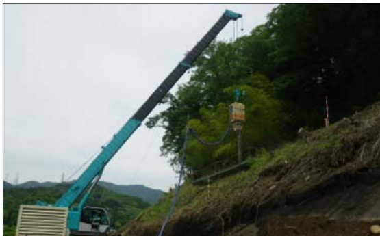
図-8 先行土留め施工状況(鋼矢板)
