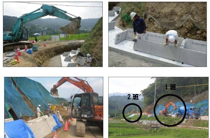
図-10 パネル組立式大型ブロック施工状況
