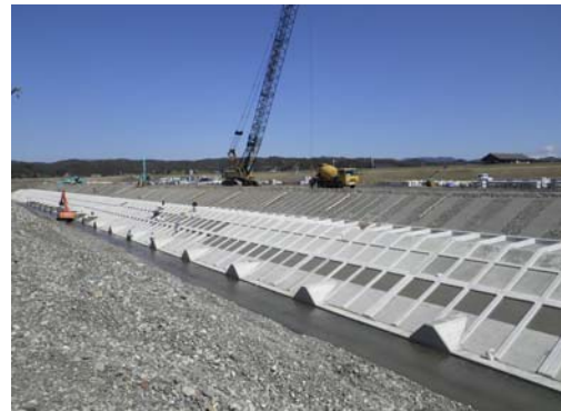
クレーン作業状況
