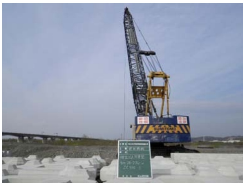
90tクローラークレーン
