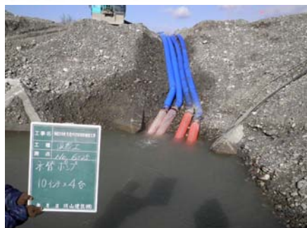
排水ポンプ設置(一部)
