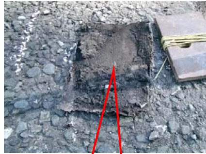
シート系防水を確認
