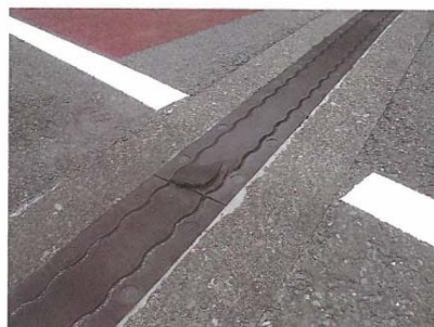
写真-6 伸縮装置状況
