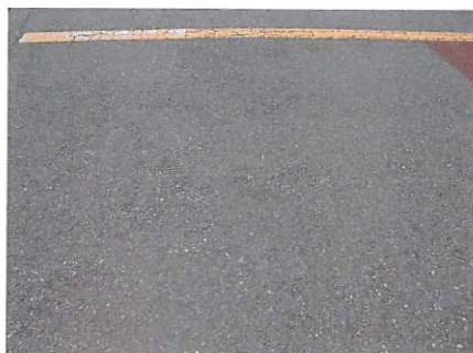
写真-5 舗装状況
