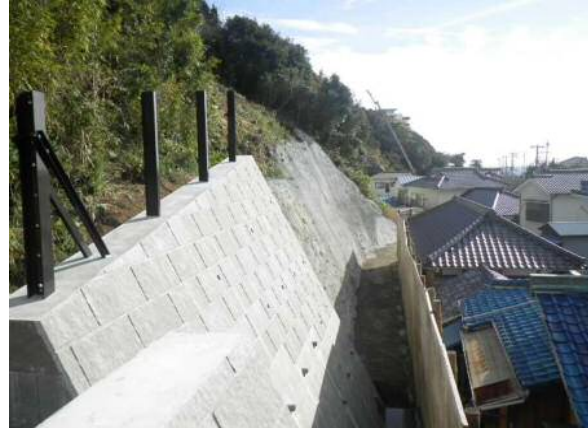
工事起点側コンクリート張工
