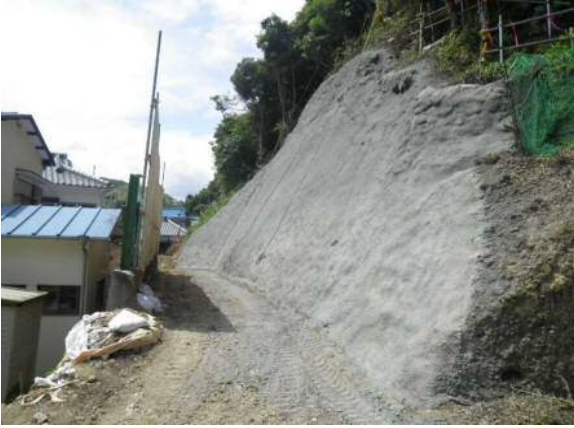
工事終点側進入路
