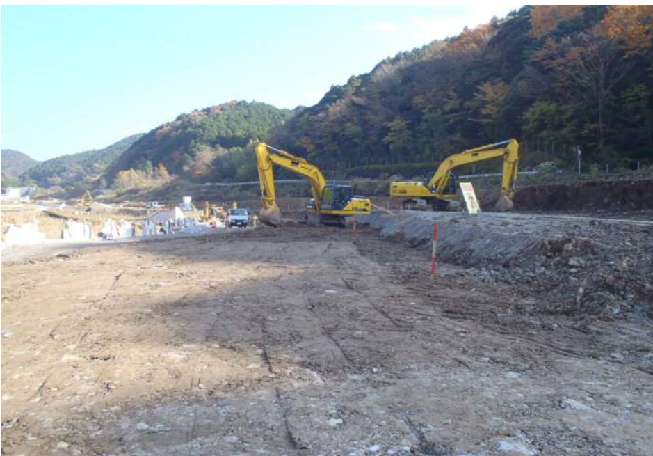
背面盛土施工状況
