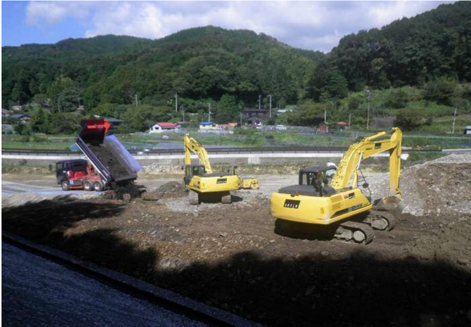
発生土搬入状況
