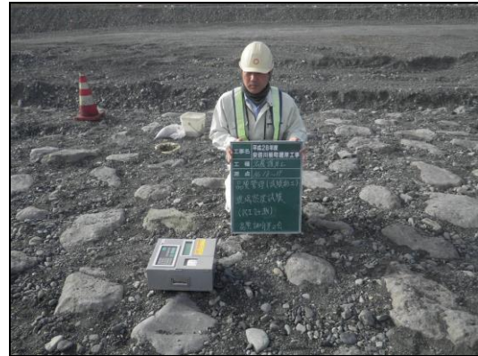
写真-8 RI計器を用いた現場密度試験
