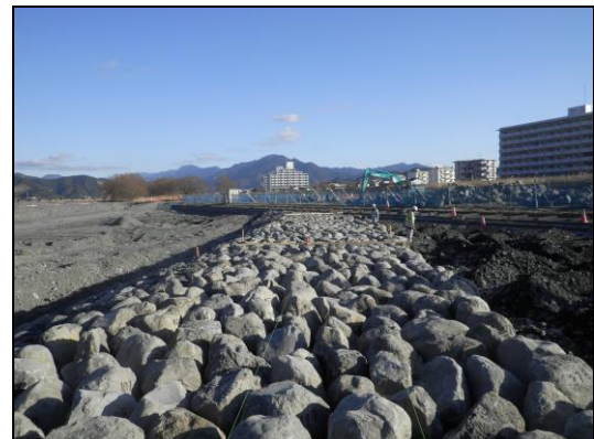
写真-3 巨石据付完了
