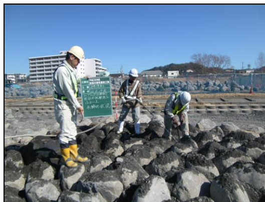
写真-5 突固め及び水締め
