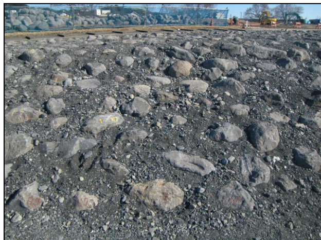
写真-6 間詰め完了
