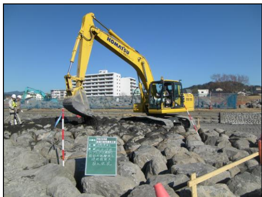
写真-4 巨石間へ間詰め材の投入
