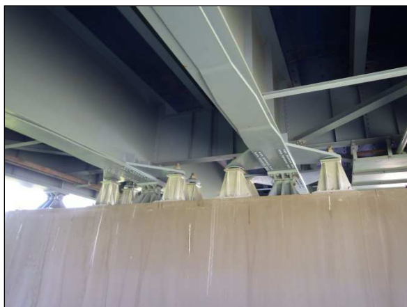
写真-5 変位制限装置工完了 全景(左)、近接(右)
