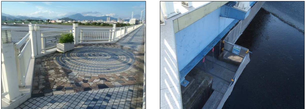
写真-3 歩道拡幅部(左) 拡幅部から足場を見下ろす(右)
