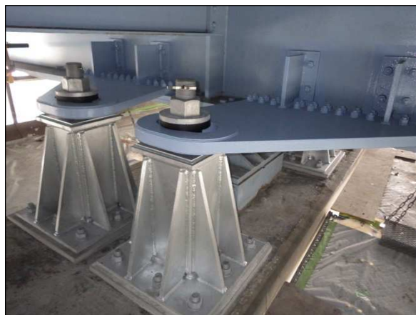
写真-5 変位制限装置工完了 全景(左)、近接(右)
