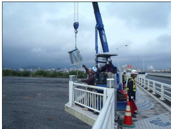
写真-4 歩道上部材運搬(左) 拡幅部からの部材入れ込み(右)
