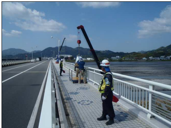
写真-4 歩道上部材運搬(左) 拡幅部からの部材入れ込み(右)
