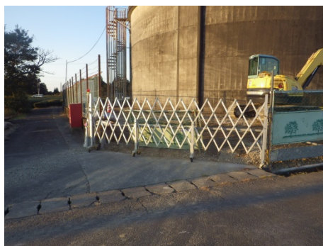
仮設出入口設置
