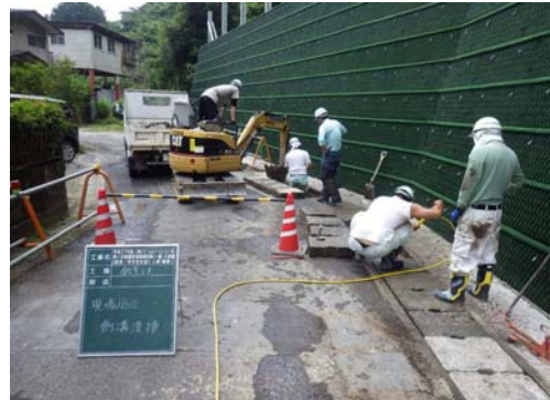
側溝清掃状況
