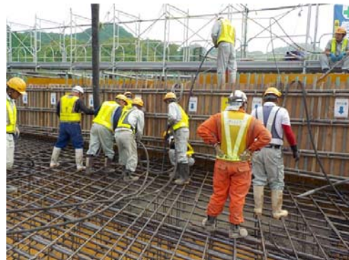
コンクリート打設状況
