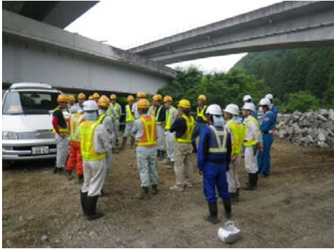
コンクリート打設前の周知会
