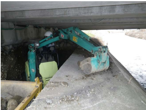
(小型バックホウ旋回状況)
