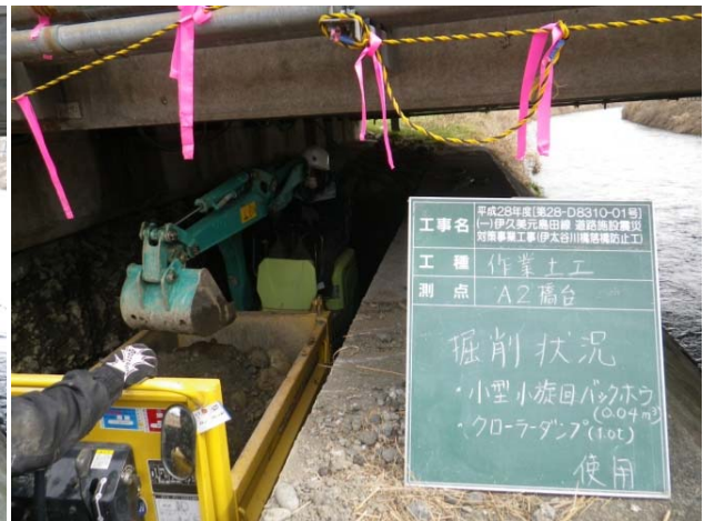
(キャラダンプへの積込状況)
