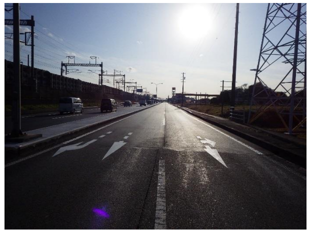
国道 150 号道路 工事完成 起点側下り線
