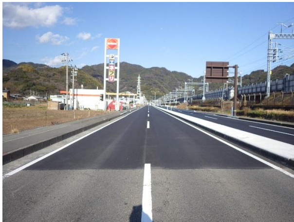
国道 150 号道路 工事完成 終点側上り線
