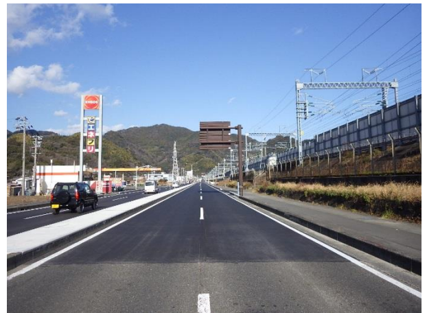
国道 150 号道路 工事完成 終点側下り線
