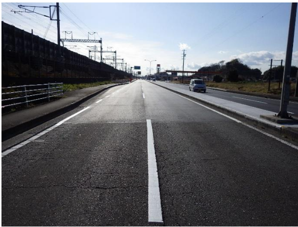
国道 150 号道路 工事完成 起点側下り線
