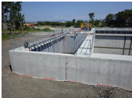
(調整槽、調整曝気槽付近) クラックなし
