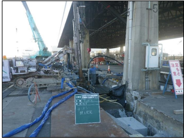
＜施工状況写真＞
