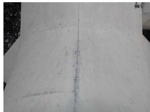
シーリング撤去後
