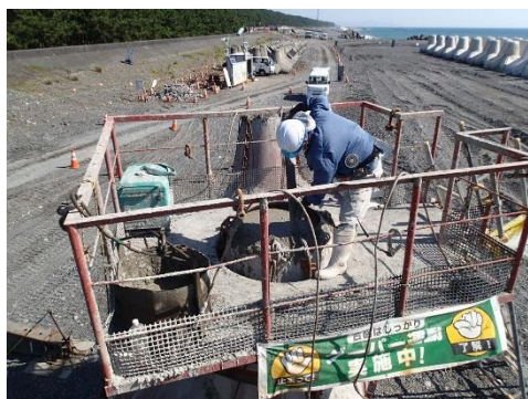
スペーシング状況
