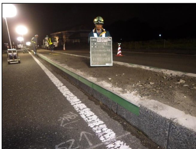
(写真 2-1 隙間テープ使用状況)
