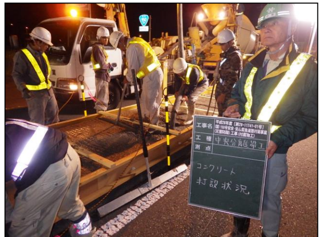
コンクリート打設状況
