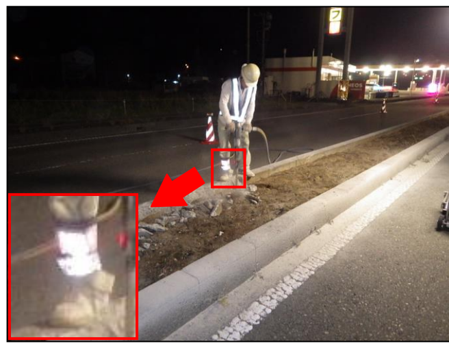
(写真 4-2 夜間作業時)
