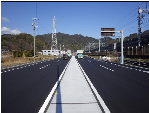
国道 150 号道路 工事完成 起点側
