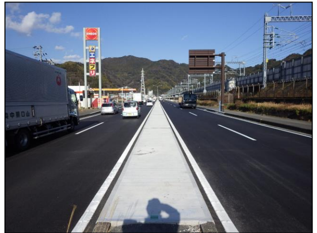
国道 150 号道路 工事完成 終点側
