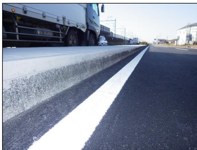
(写真 2-2 型枠脱型後)
