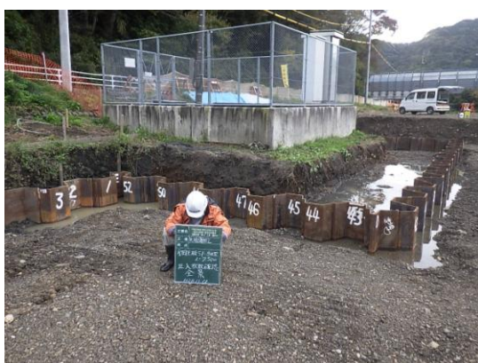
鋼矢板打込完了
