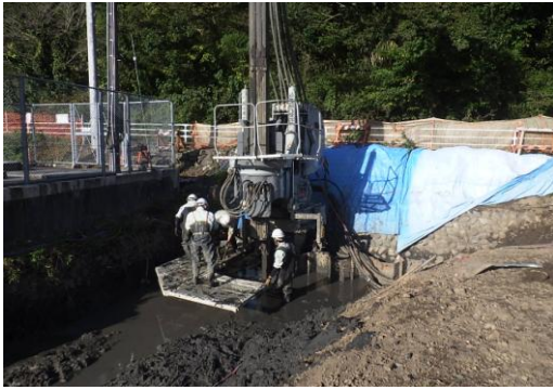
クラッシュハ°イラー 先行作業状況
