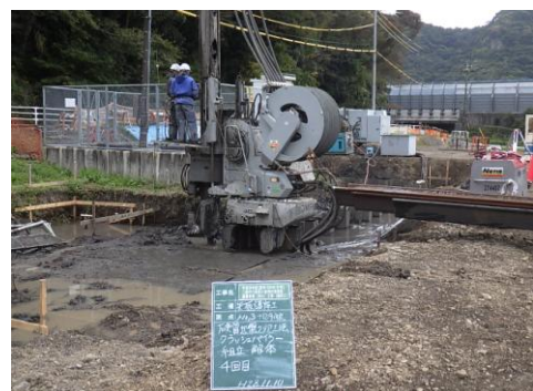
組立解体 4回目
