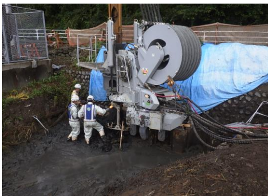
組立解体 1回目
