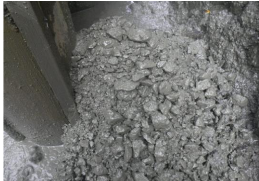
硬質岩排出状況
