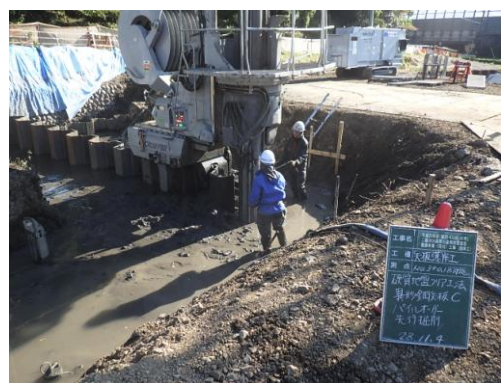
組立解体 2回目
