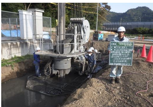
組立解体 3回目
