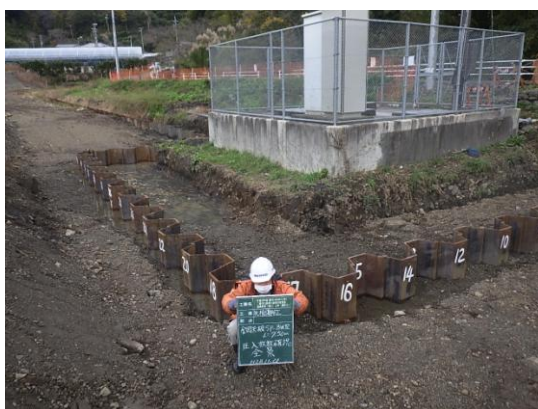
鋼矢板打込完了
