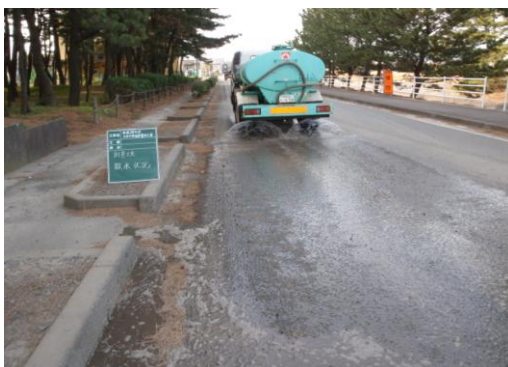
埃対策・散水状況
