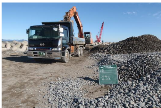
掘削・ダンプ積込状況
