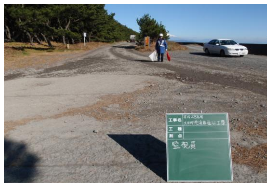
搬入路・監視員配置
