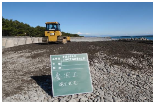
ブルドーザー敷均し作業状況
